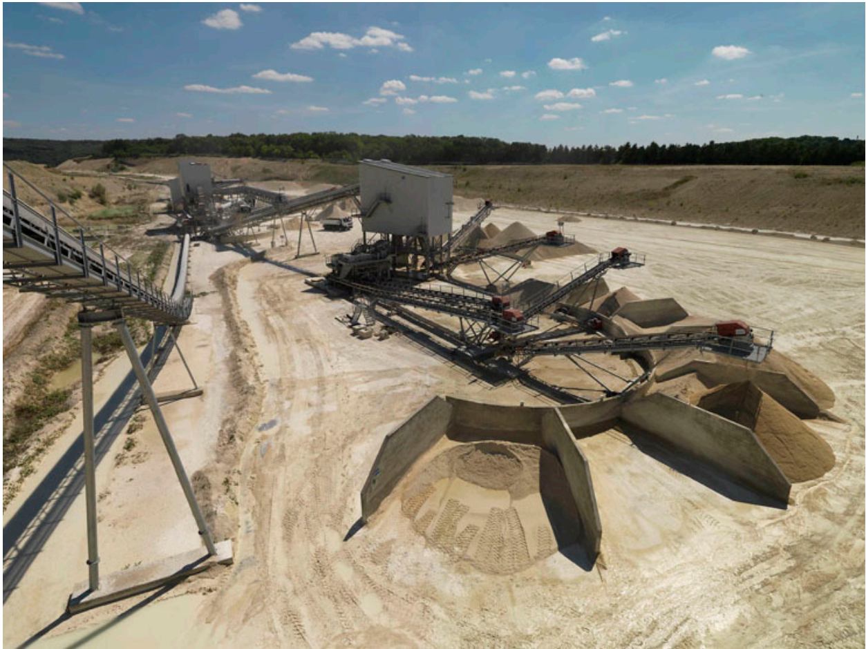
Plateforme - installation secondaire.
