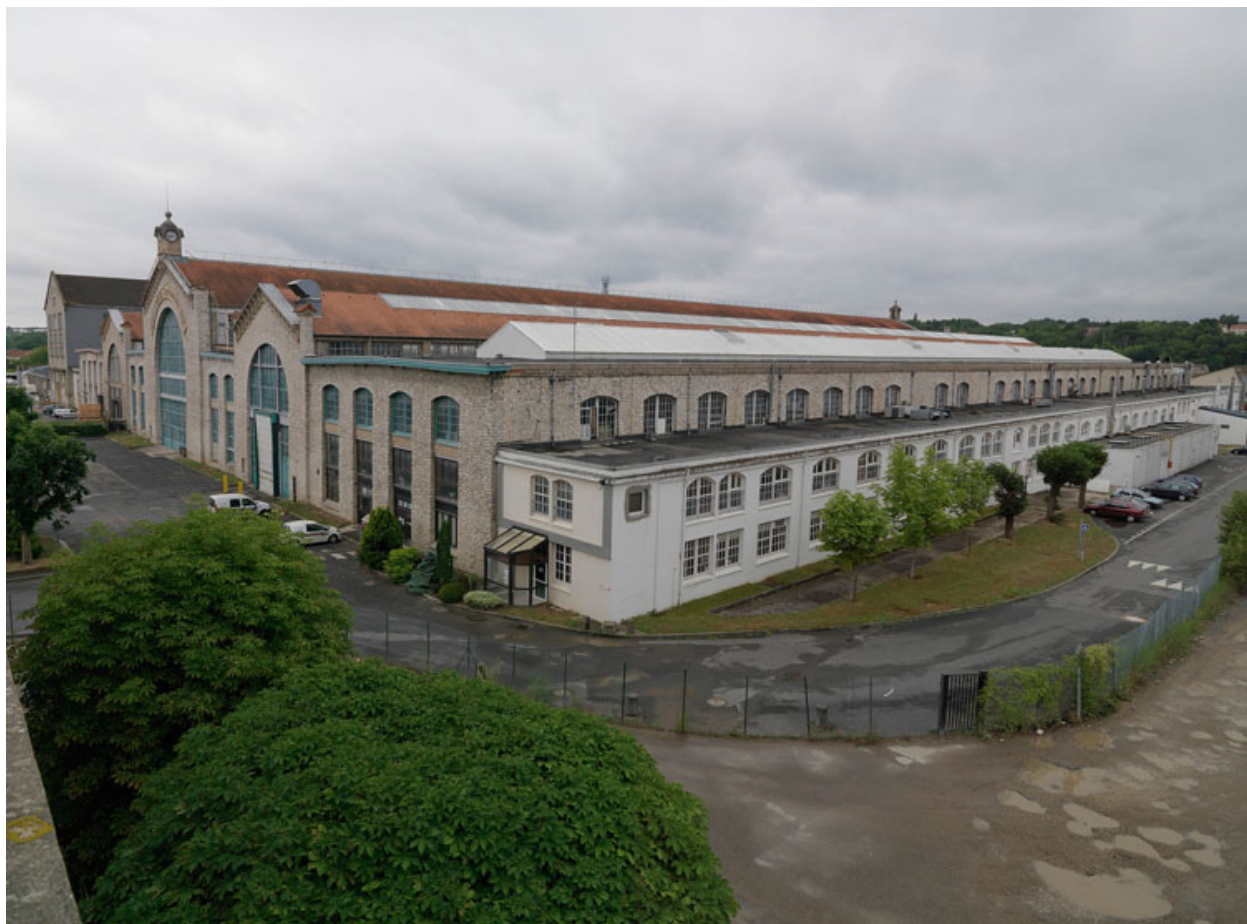
Vue générale de l'usine côté nord. Au premier plan, l'agrandissement nord : bobinage (1916)
