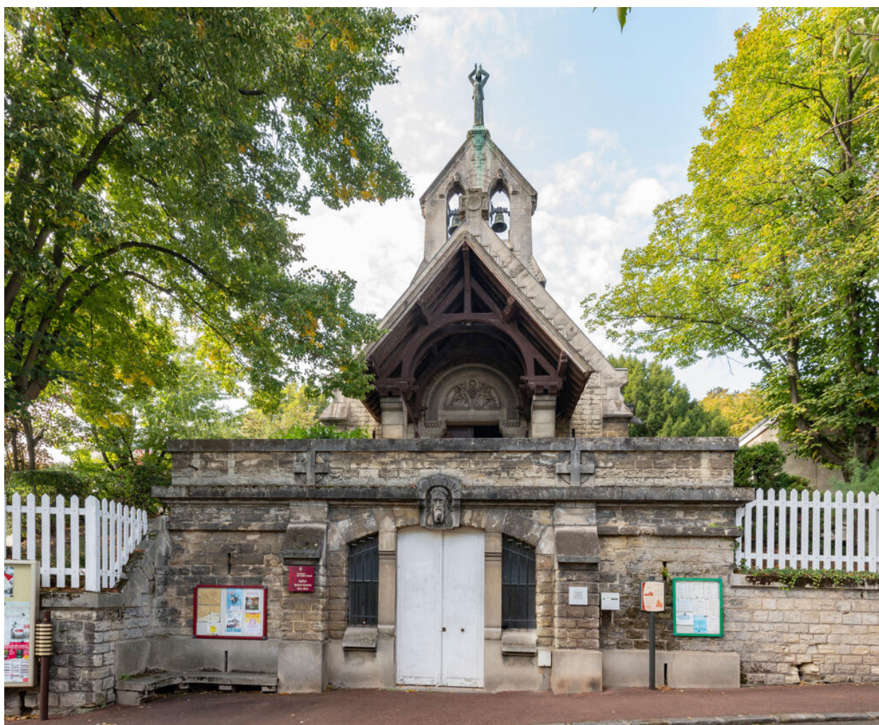
Chapelle Notre-Dame-des-Airs, vue générale depuis la rue
