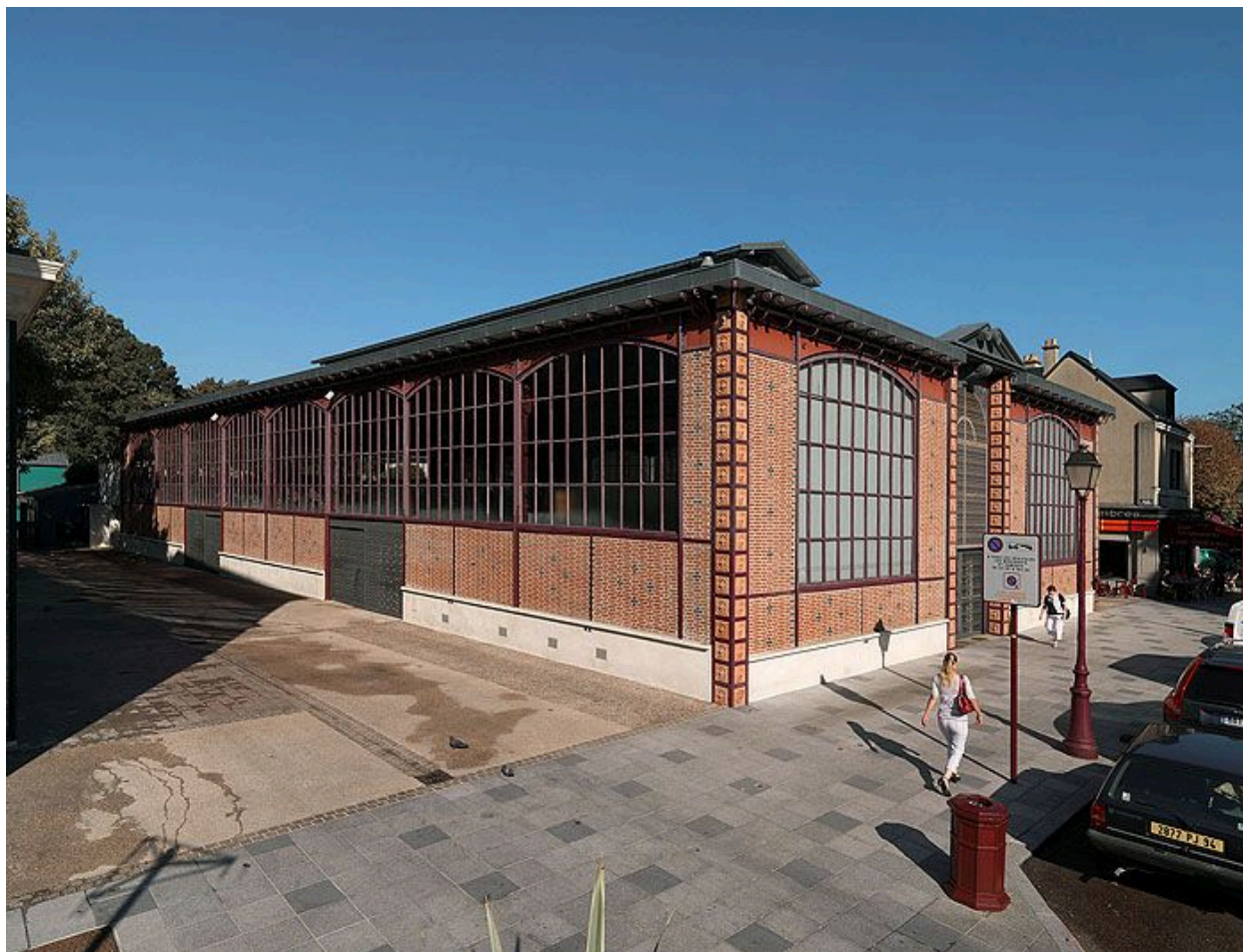
92, Sceaux, marché du Centre, 64 avenue du Président-Francklin-Roosevelt. Elévation générale extérieure.
