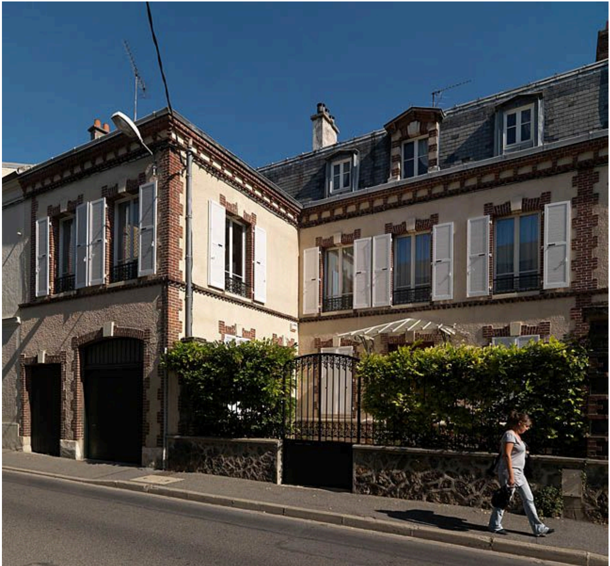
Vue de la maison au n°18, avec son annexe à porte cochère, alignée sur la rue.
