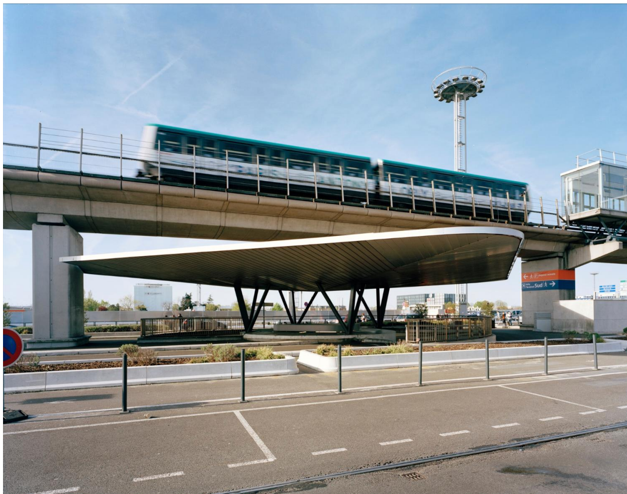
2018, l'Orlyval et la station d'Orlyval d'Orly-Sud, vus depuis le parvis d'Orly-Sud (sud).
