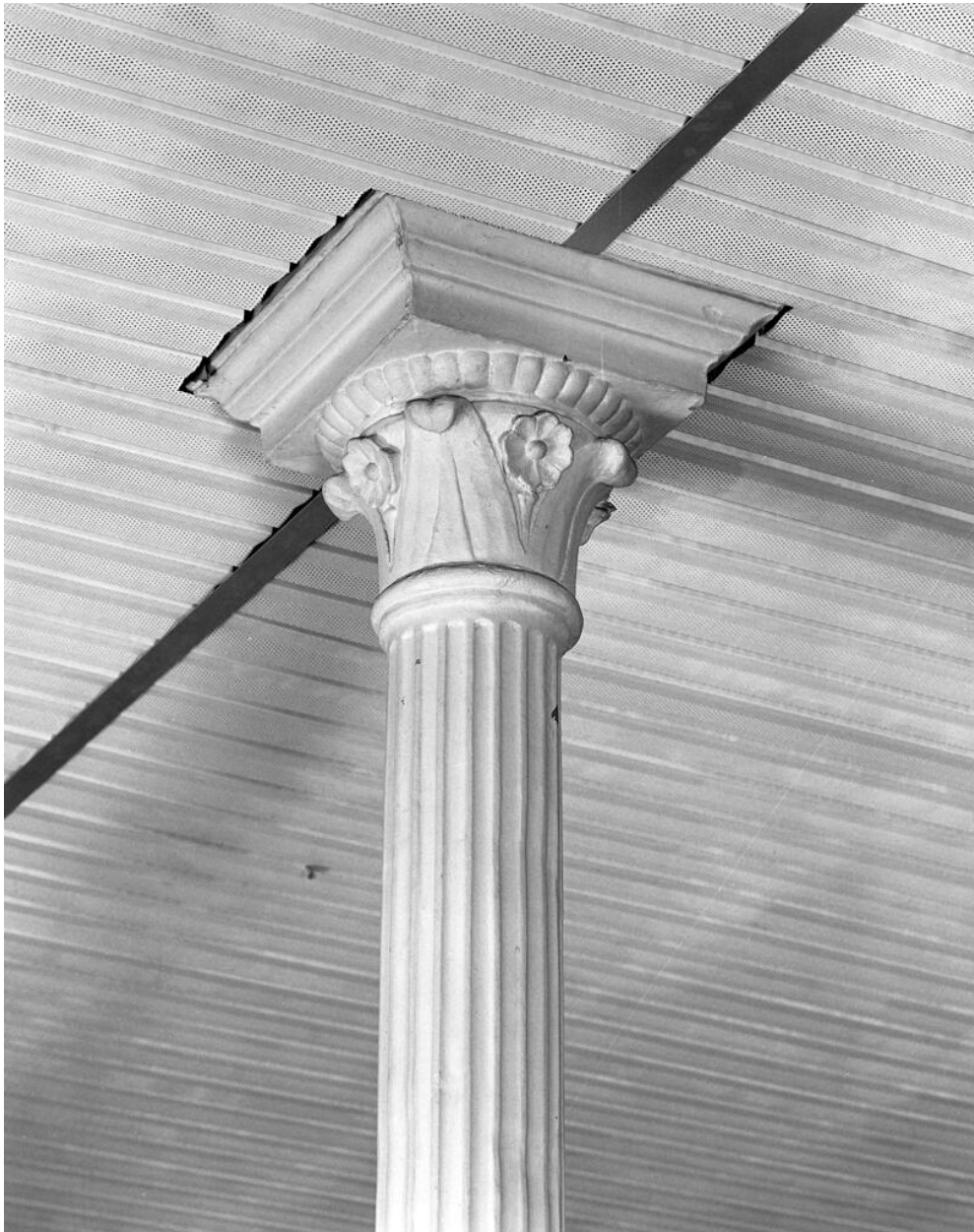
Le Moyen Collège : la salle de spectacle, détail d'un chapiteau de fonte. Château, Lycée dit Château de le Prevost puis DESCONDE, Lycée du Prince Impérial, actuellement Lycée Michelet
