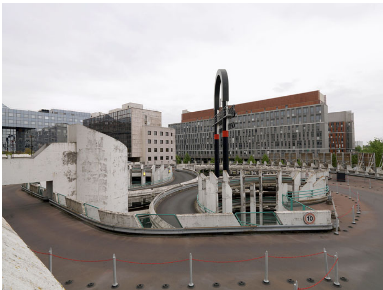
Parking régional du Mont d'Est, 1975-1977. Rampes d'accès.
