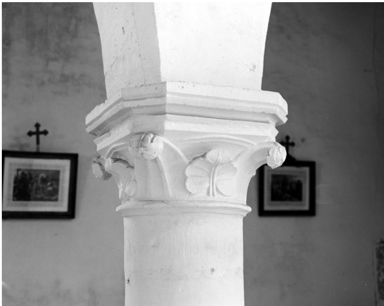
Chapiteau de la première colonne (état en 1991).
