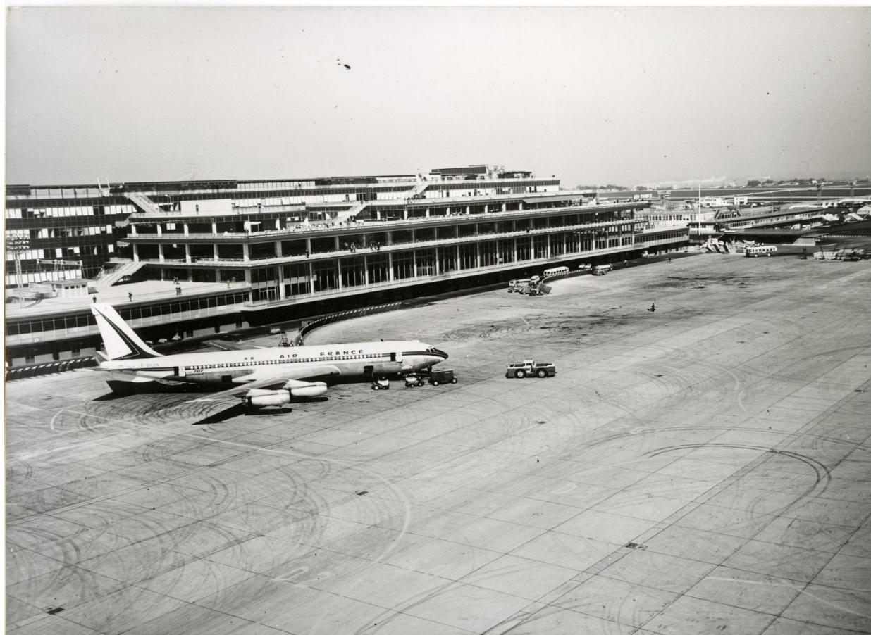
1961 février octobre, les travaux de jonction des Installations Terminales et de l'Aérogare-Sud, vus depuis le sud.
