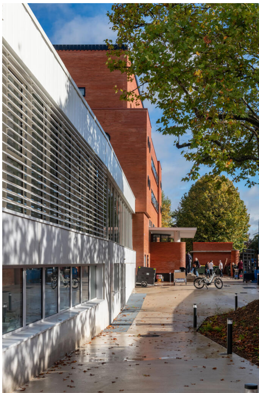
Piscine Alice Milliat. Vue longitudinale des façades depuis l'extension.
