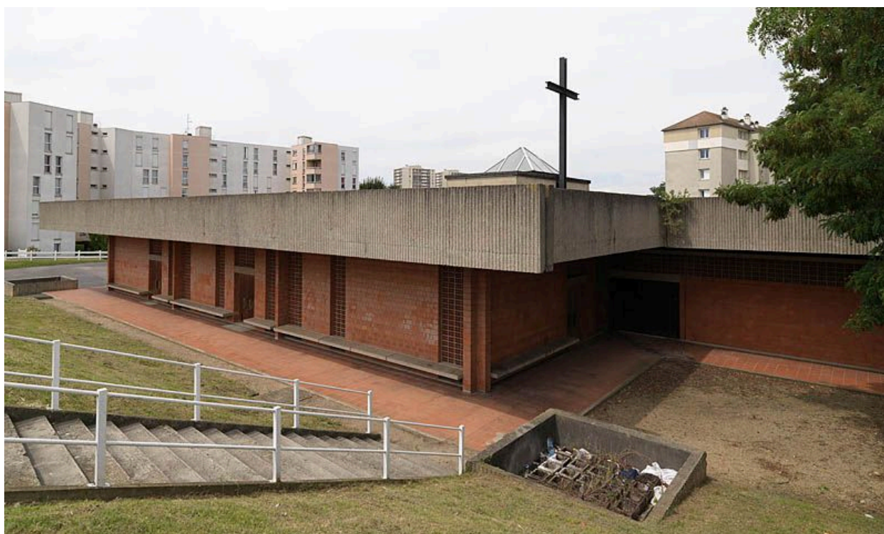
Façade sud depuis le sud-est.
