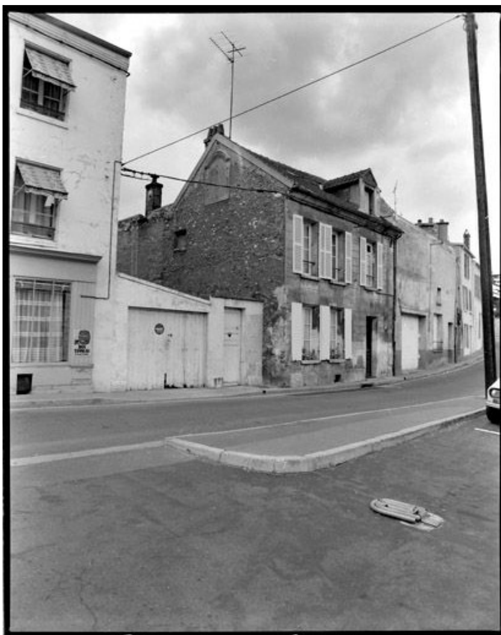
Maison, Porte Chante-à-l'oie (rue) 15. Vue de la façade sur rue.
