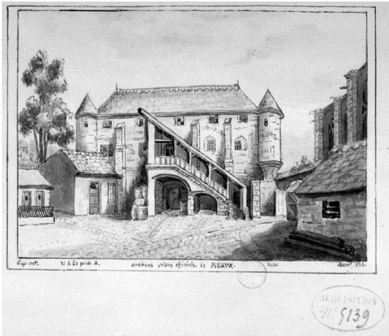
La façade sur cour du "Vieux-Chapitre", en 1834. La façade sur cour du "Vieux-Chapitre. (BNF. Département des estampes, TopoVa Seine-et-Marne, H 156268)
