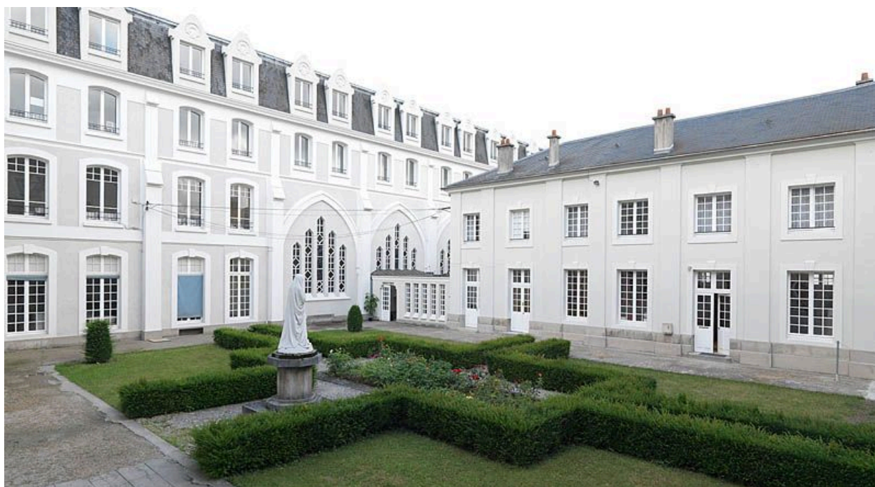
Jardin intérieur. Façade Nord de la chapelle de 1936 et Est de l'ancienne chapelle des visitandines.
