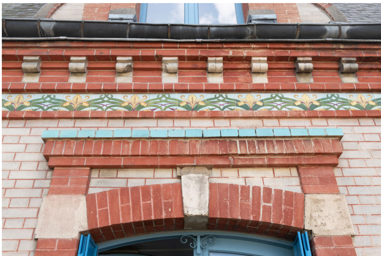
Détail de la fenêtre centrale du premier étage.
