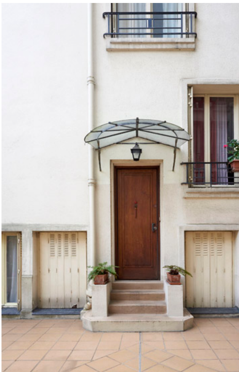
Vue de la porte desservant l'immeuble en retour, côté droit.
