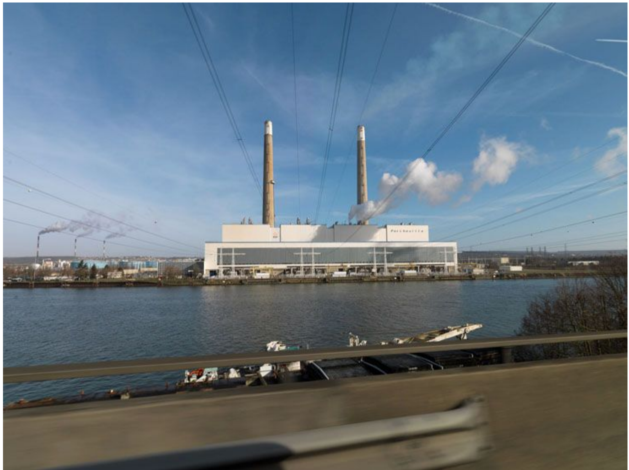
Porcheville, vue de la centrale EDF depuis l'autoroute A13.
