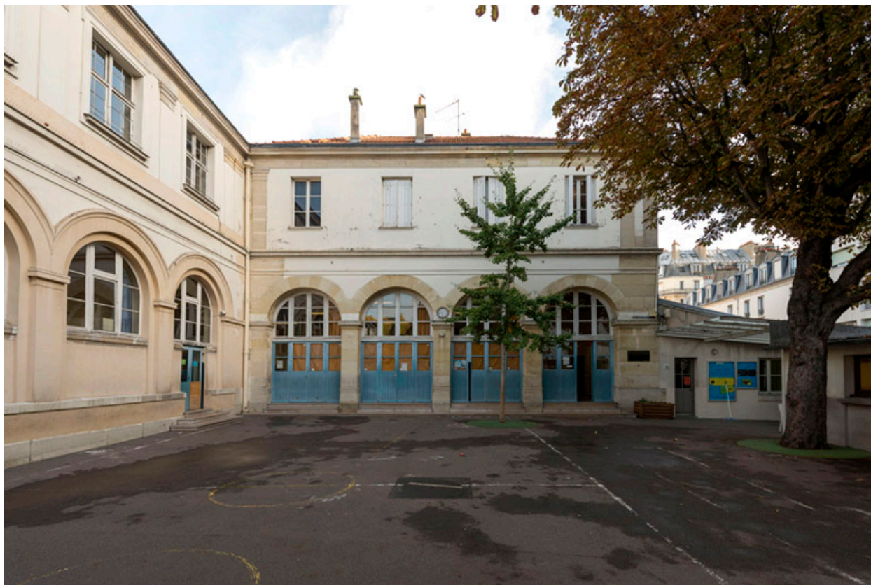
Vue du bâtiment abritant la salle de gymnastique.
