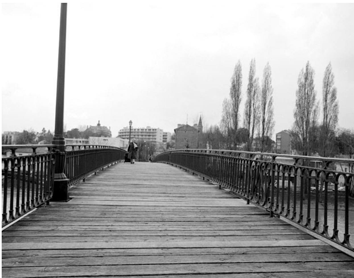
Vue depuis la passerelle de Bry. Au fond, à gauche: la mairie. Au fond, à droite: la mairie.
