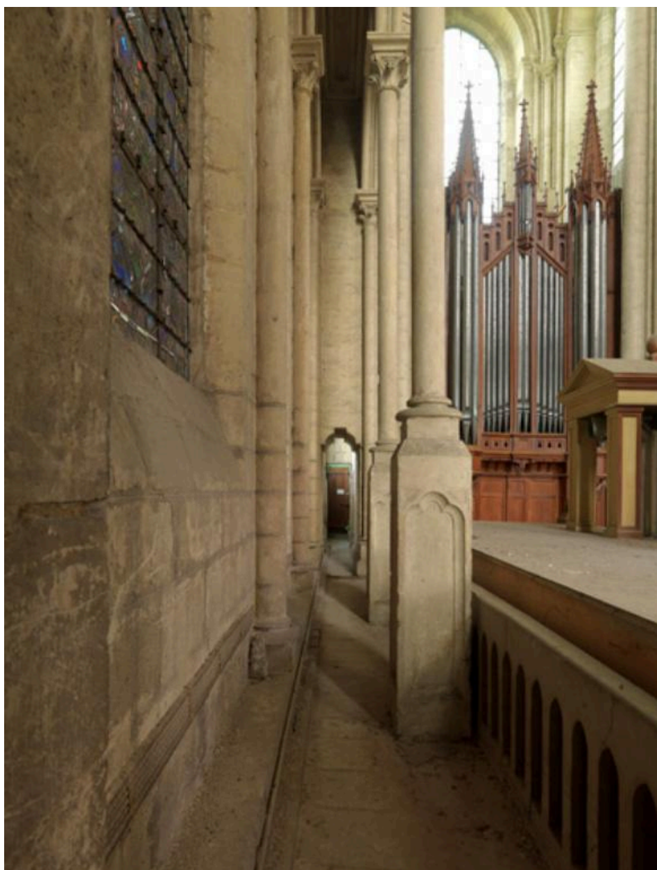
Passage dédoublé le long de façade occidentale.
