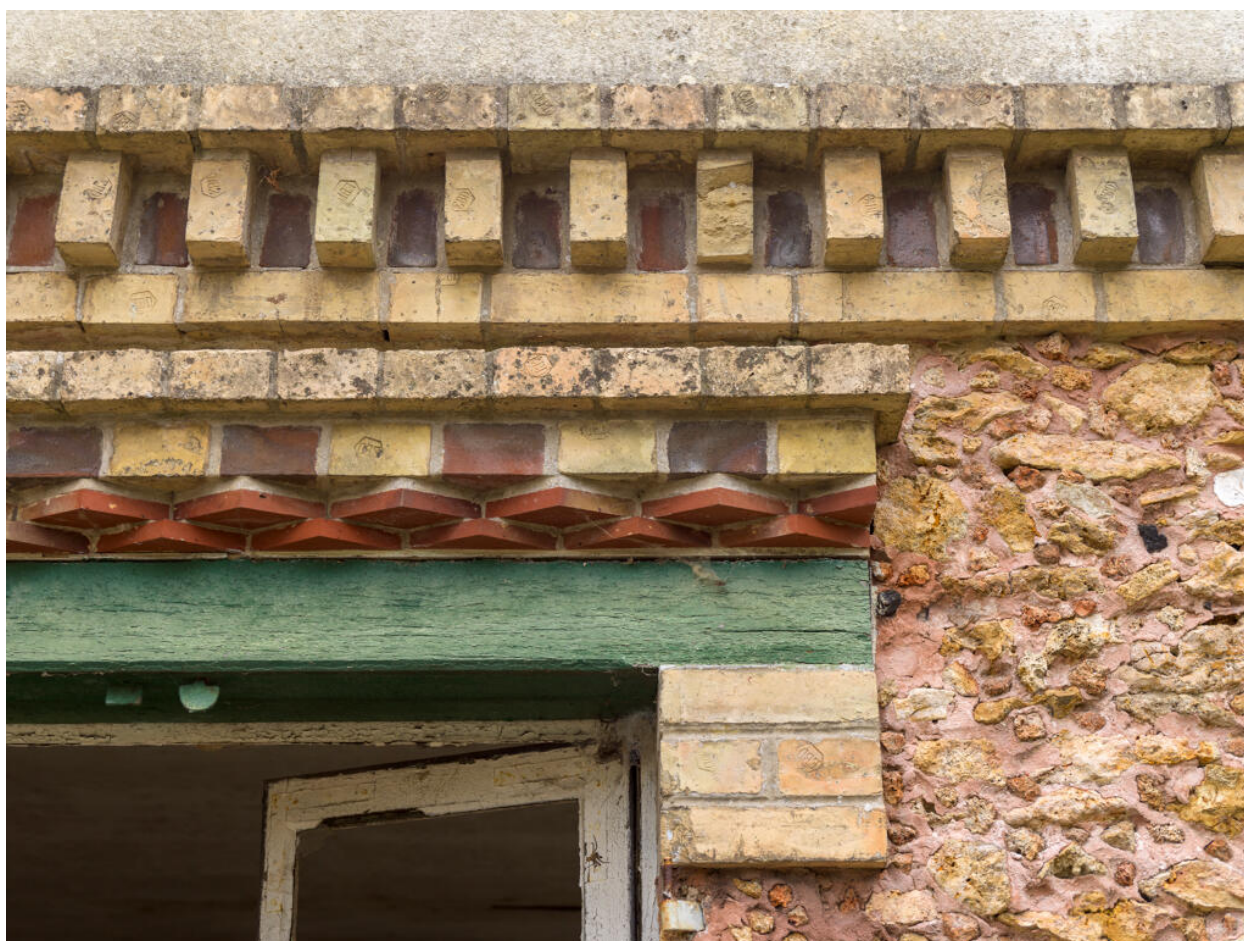
Maison d'Octave Allaire, détail de la modénature, alternant les mises en œuvre de la brique
