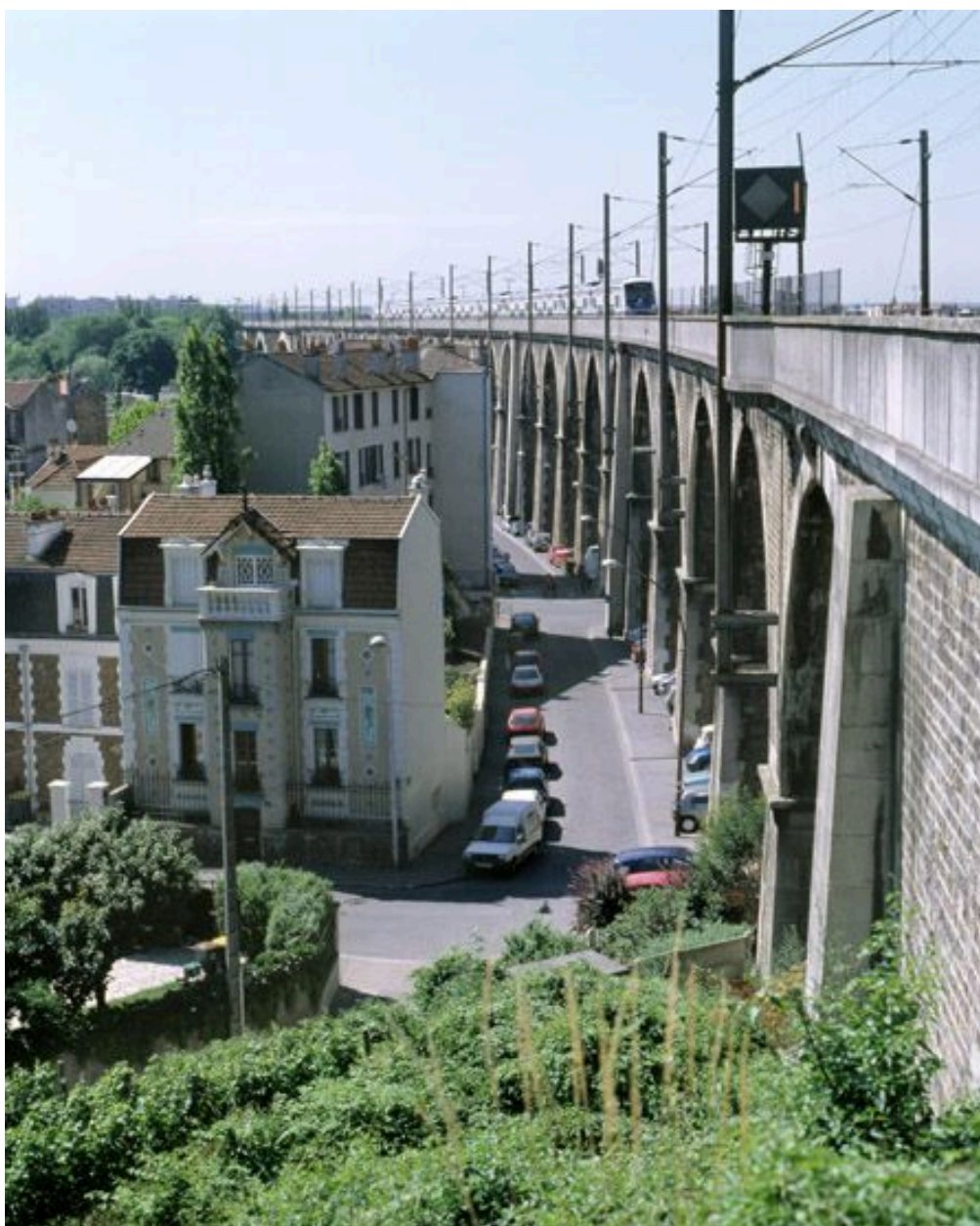
Vue du viaduc depuis le haut de la butte, vers la Marne.
