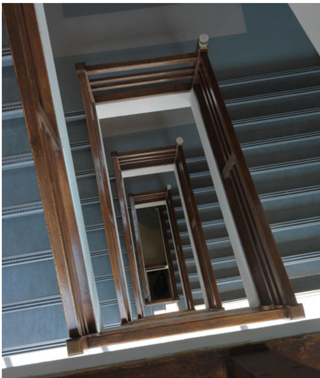
Vue plongeante de l'escalier, prise du 5e étage.
