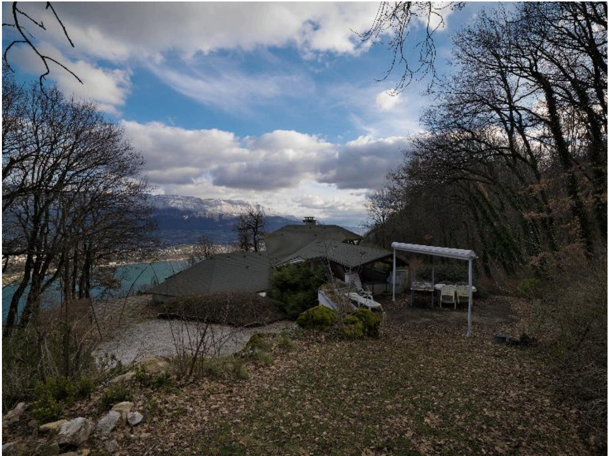
Vue des toits, prise en surplomb.
