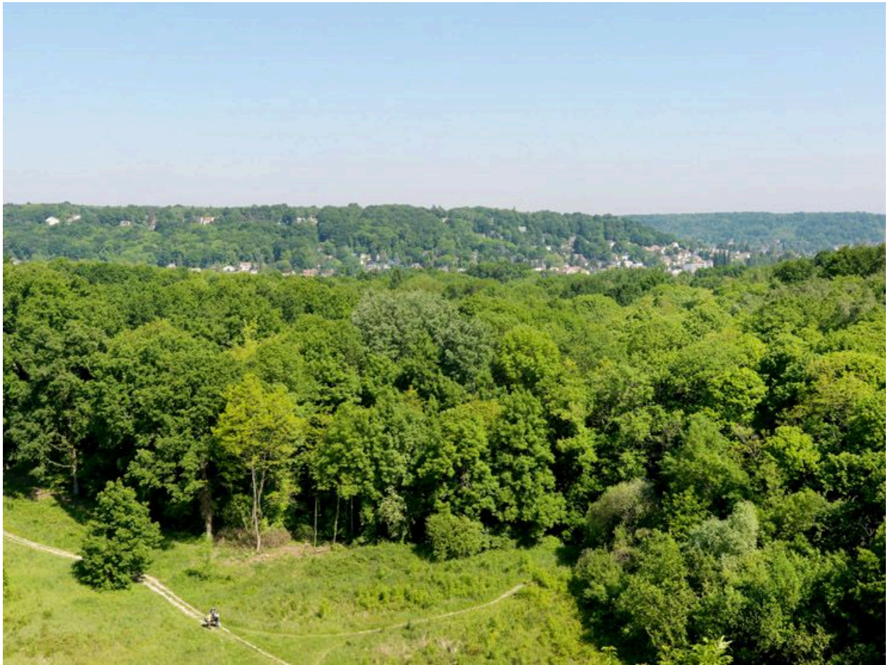
Gometz-le-Châtel. Vue vers Gif-sur-Yvette depuis le viaduc des Fauvettes.
