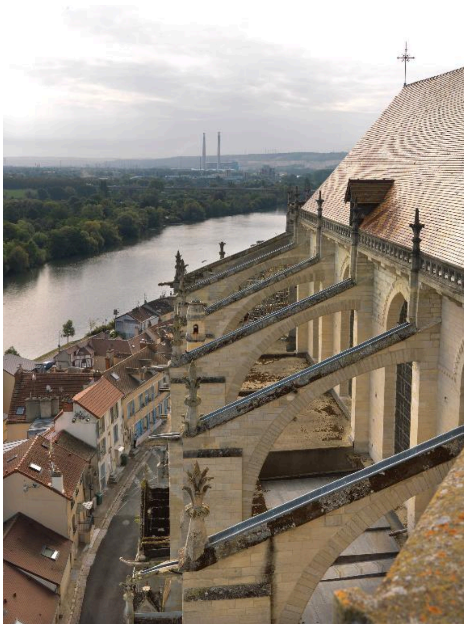
Vue des arcs-boutants de la façade nord.
