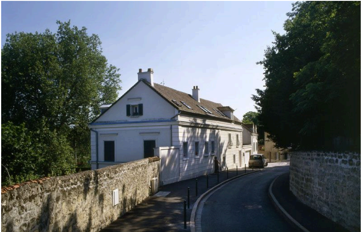
Vue d'ensemble de la façade sur rue.
