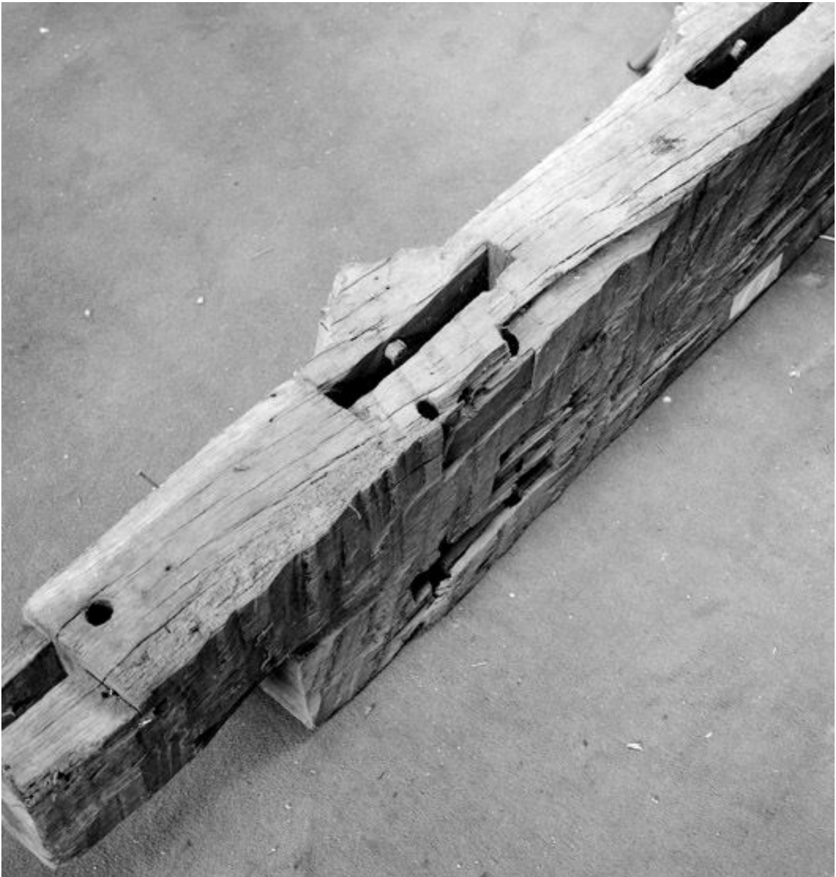
Boiseries de l'hôtel Le Cocq, déposées au prieuré Saint-Sauveur : détail d'un des éléments horizontaux de la galerie (16e siècle) montrant le mode d'assemblage des boiseries.
