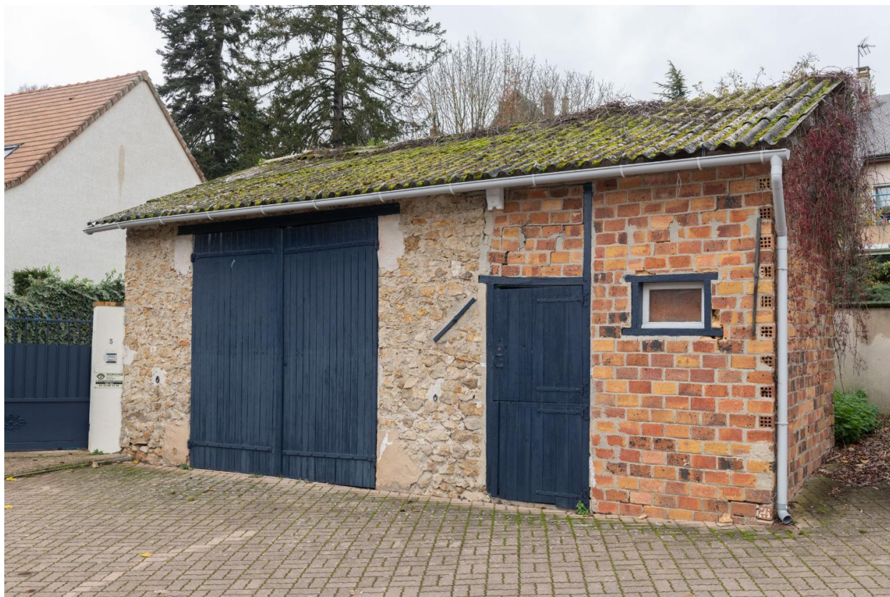
Ancienne écurie à l'entrée de la propriété
