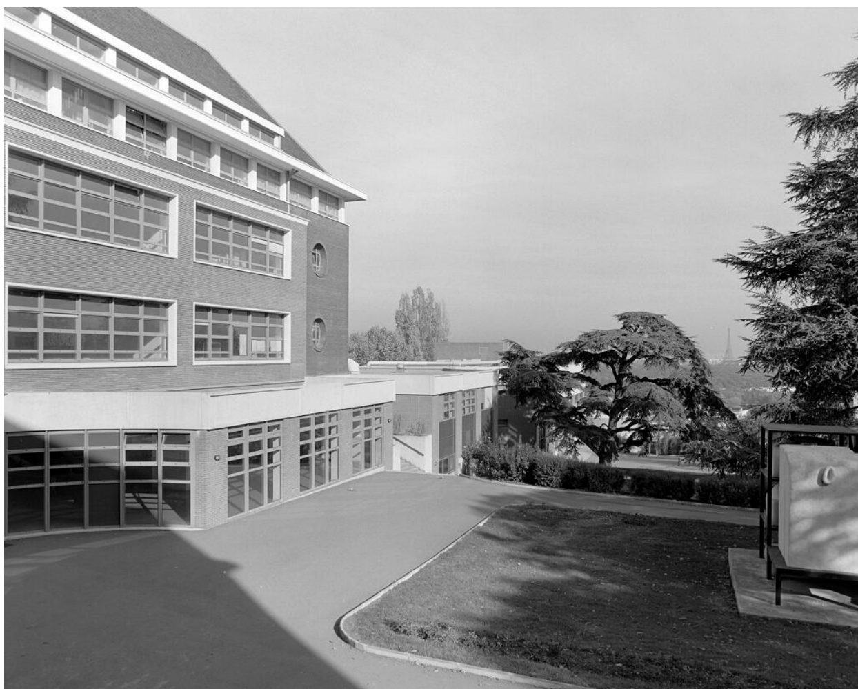
Collège Emile Verhaeren, bâtiment de classes construit entre 1938 et 1950
