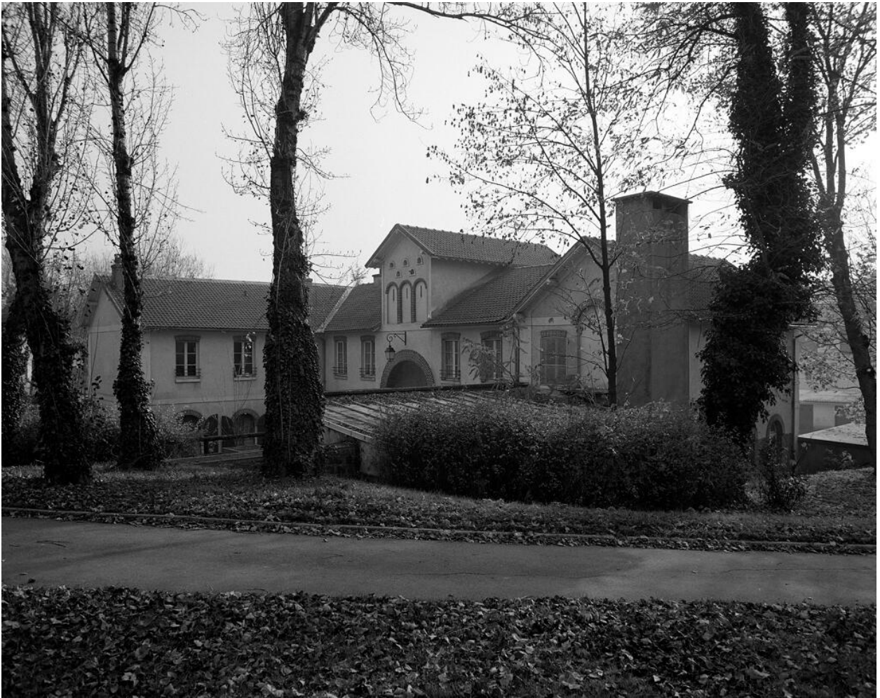
Vue d'ensemble des façades nord et ouest des communs de l'ancienne maison Arouet construits sur un terrain en cuvette.
