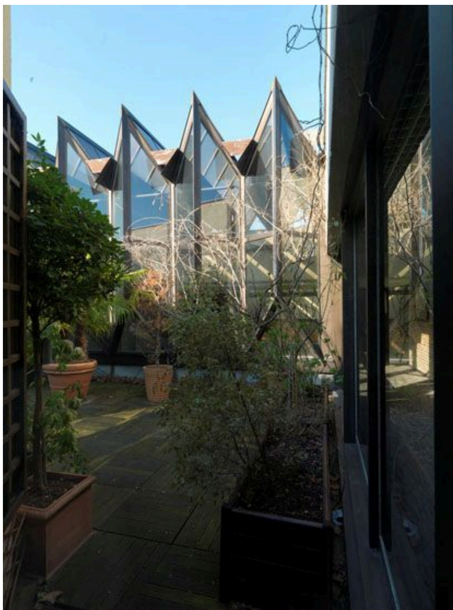
Détail des shed de verre depuis le jardin intérieur situé au premier étage.
