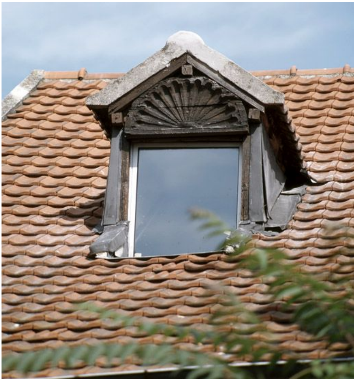
Détail de la lucarne sur le toit du restaurant La bonne Auberge, 47 quai d'Artois.
