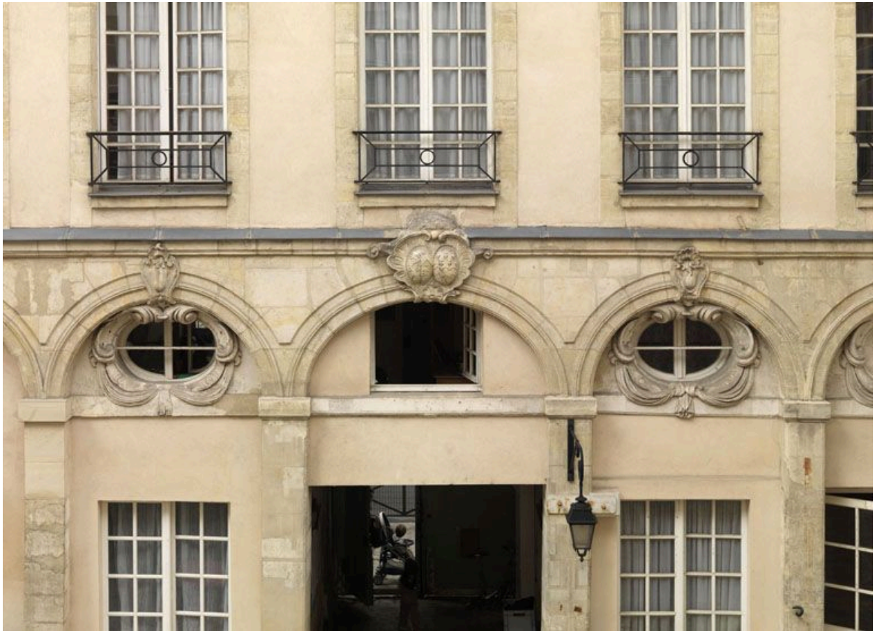
Le revers de la façade transformée vers 1742.
