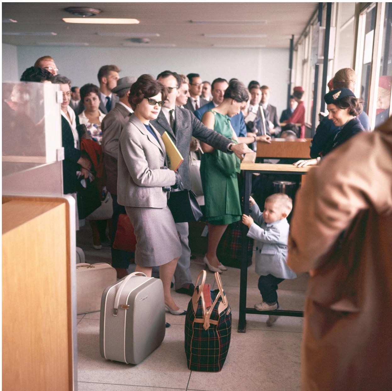
1961, salle d'embarquement, rez-de-chaussée coté piste.
