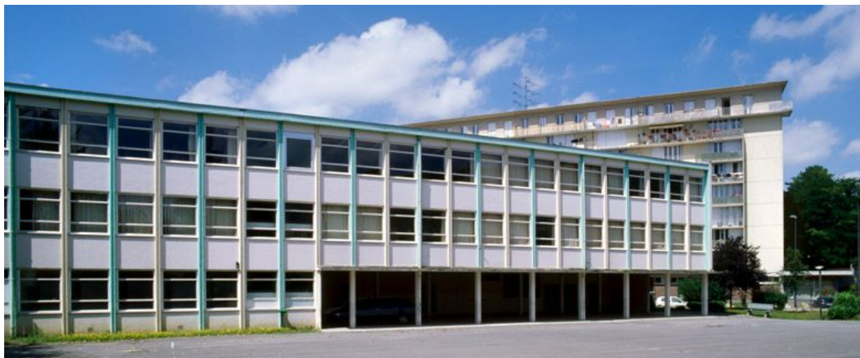
Ecole primaire : façade sur la cour.
