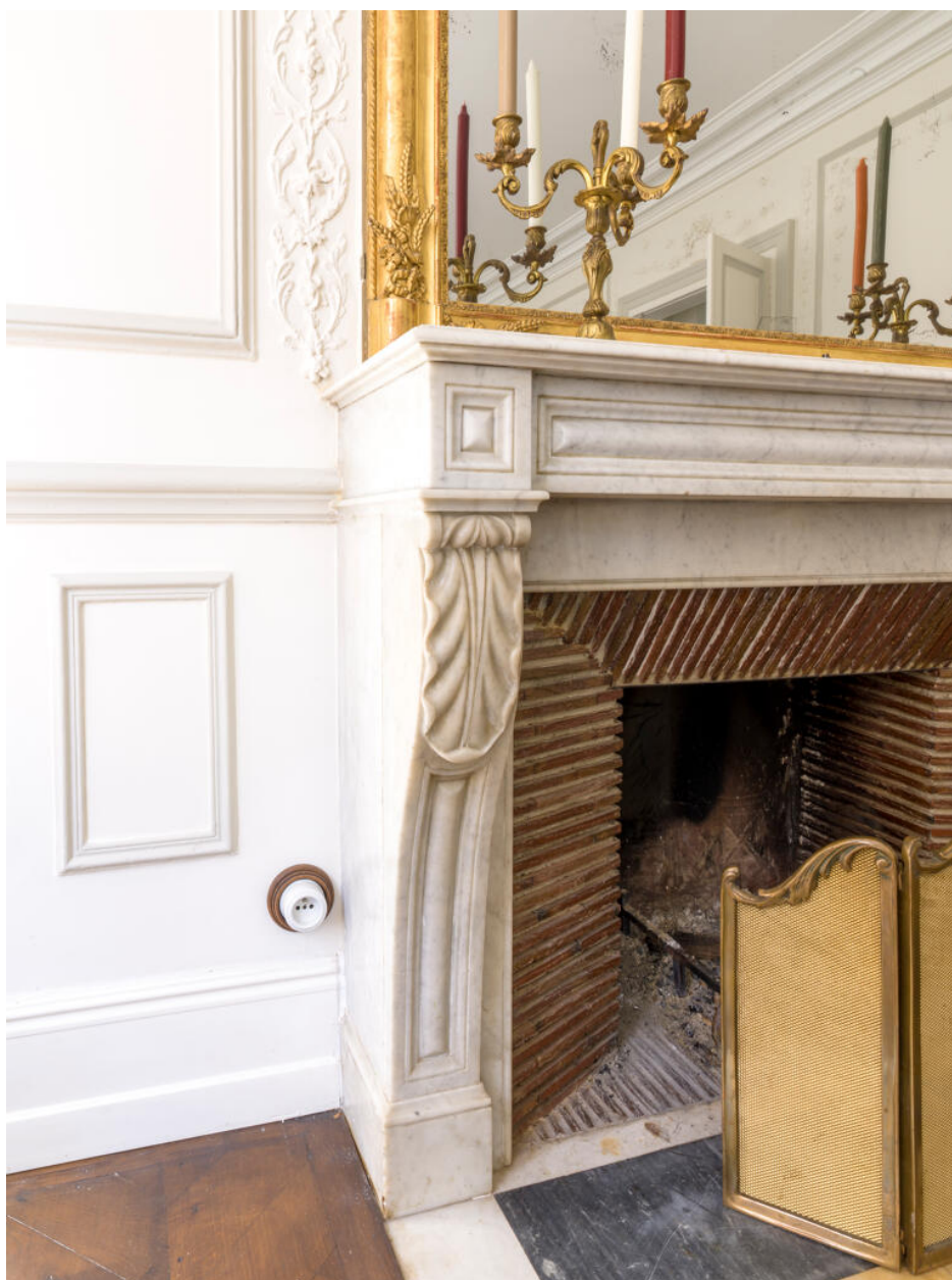
Détail de la cheminée.
