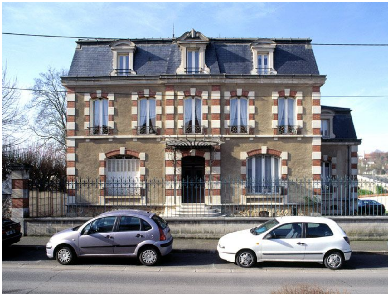
Maison de maître, 21 rue Delaunoy.
