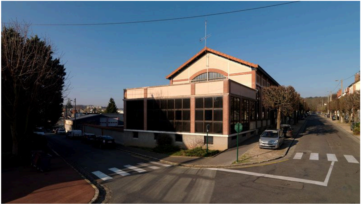
Vue générale du bâtiment des machines de la centrale électrique.
