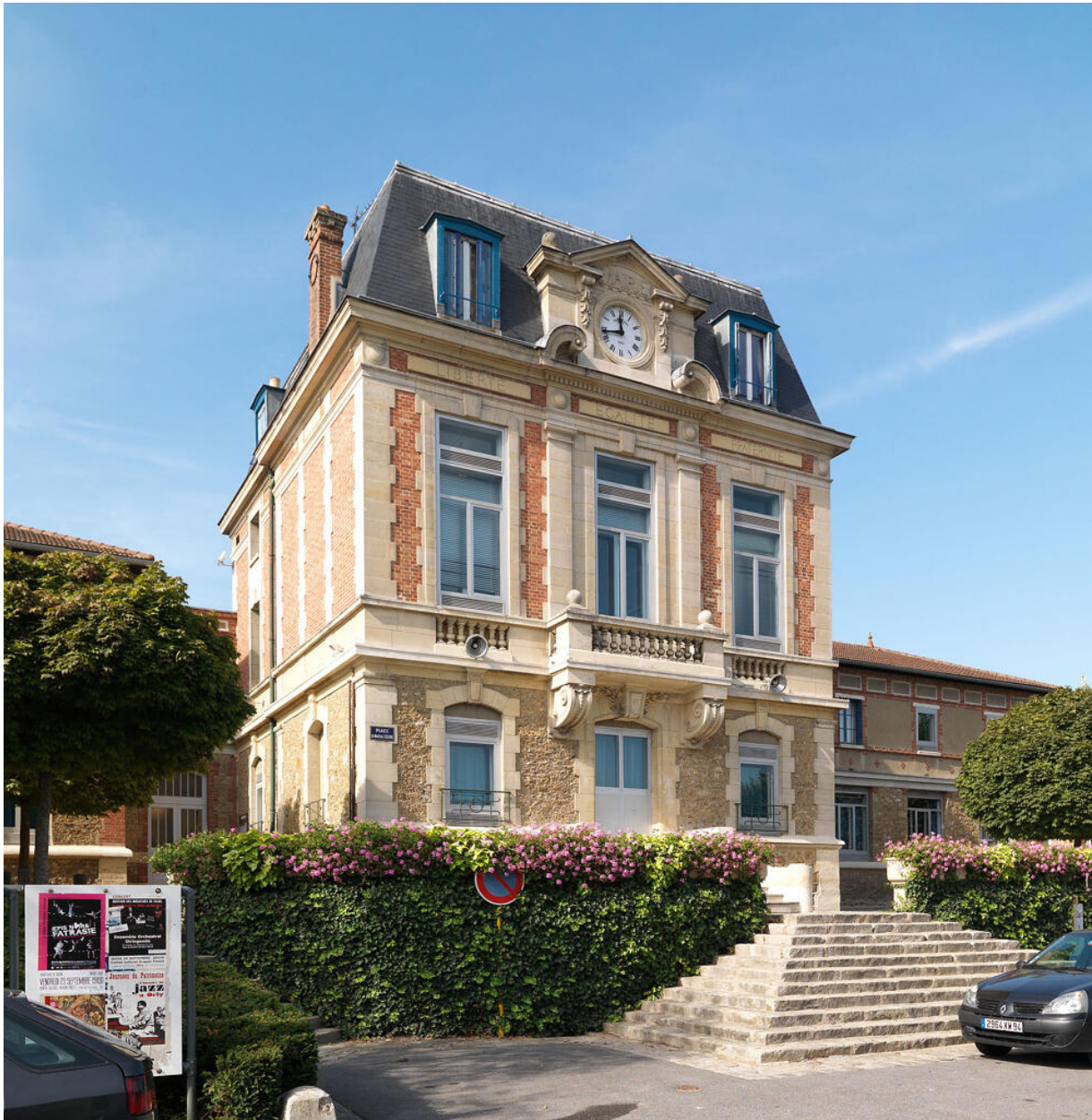
Vue extérieure de la mairie d'Orly.
