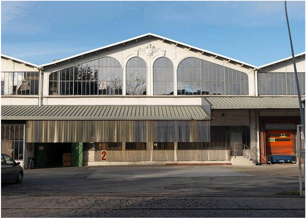
Ivry-sur-Seine, usine de confection dite fabrique de matelas Bauve, 62 rue Maurice-Gunsbourg. Elévation extérieure en 2009.
