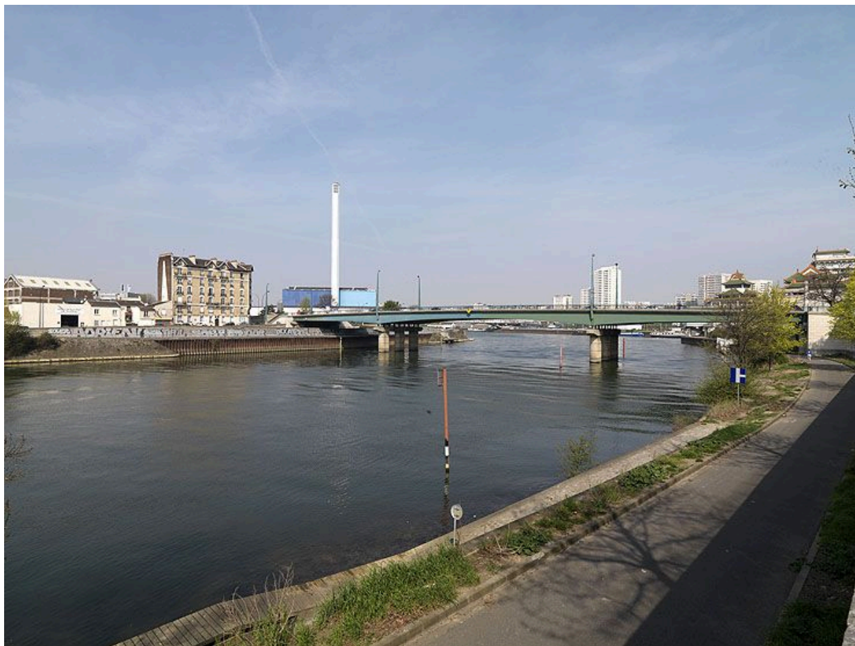
Ivry-sur-Seine, Alfortville. Pont d'Ivry (n°2). Vue d'ensemble.
