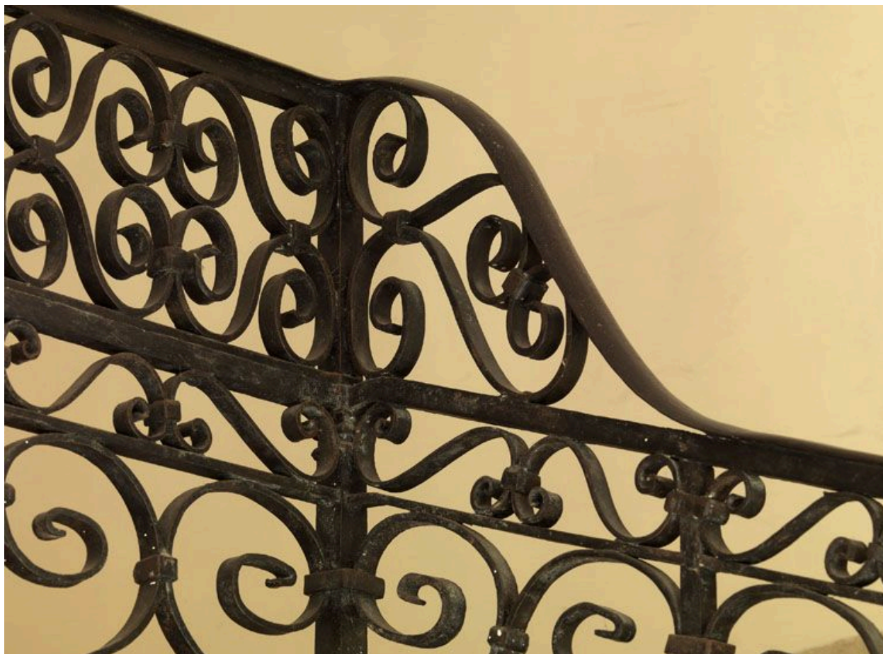
L'escalier qui desservait le pavillon de la Reine, détail de l'amortissement du dernier palier.
