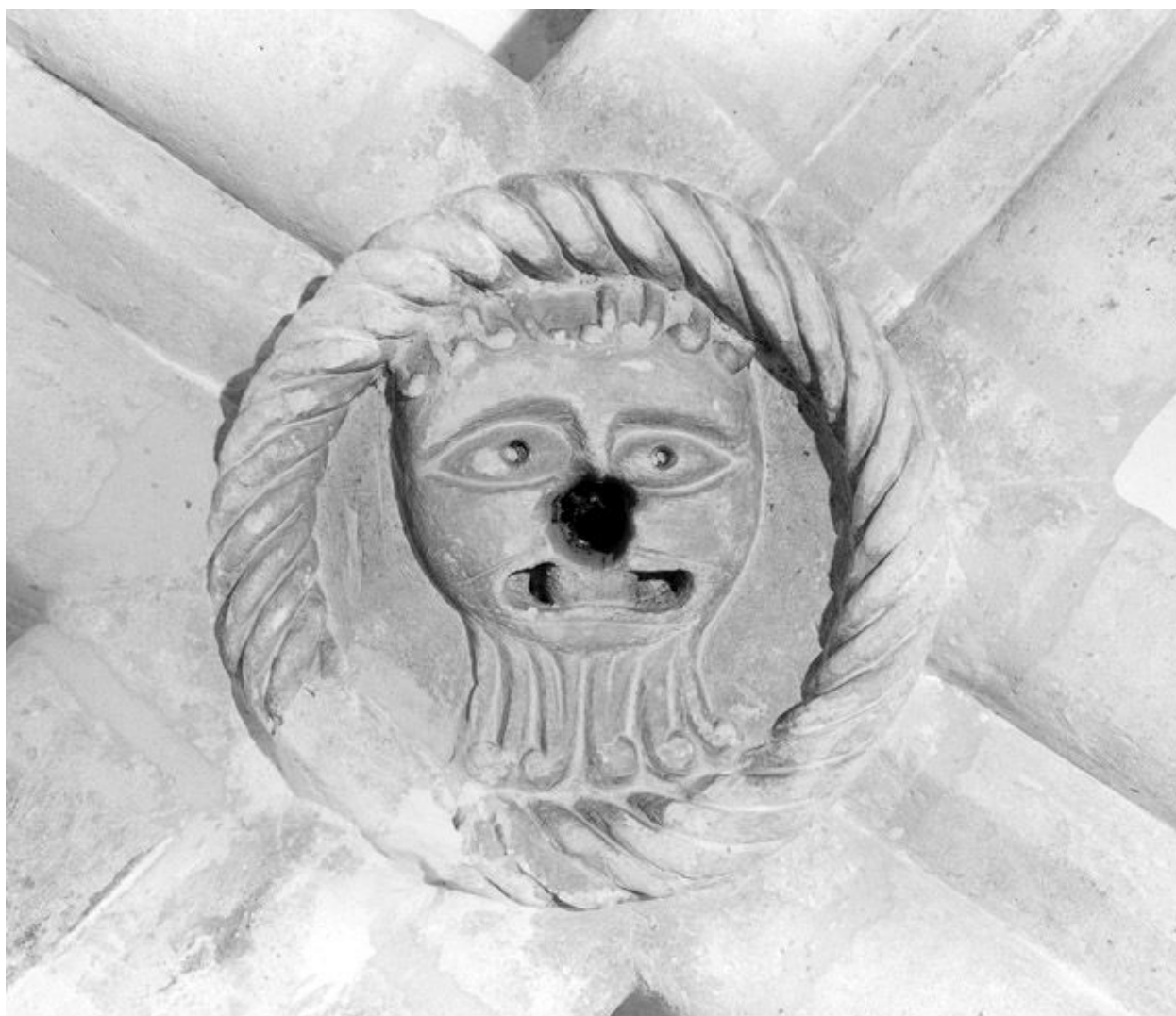
Clé de voûte de la nef, vue depuis un échaffaudage en 2005.
