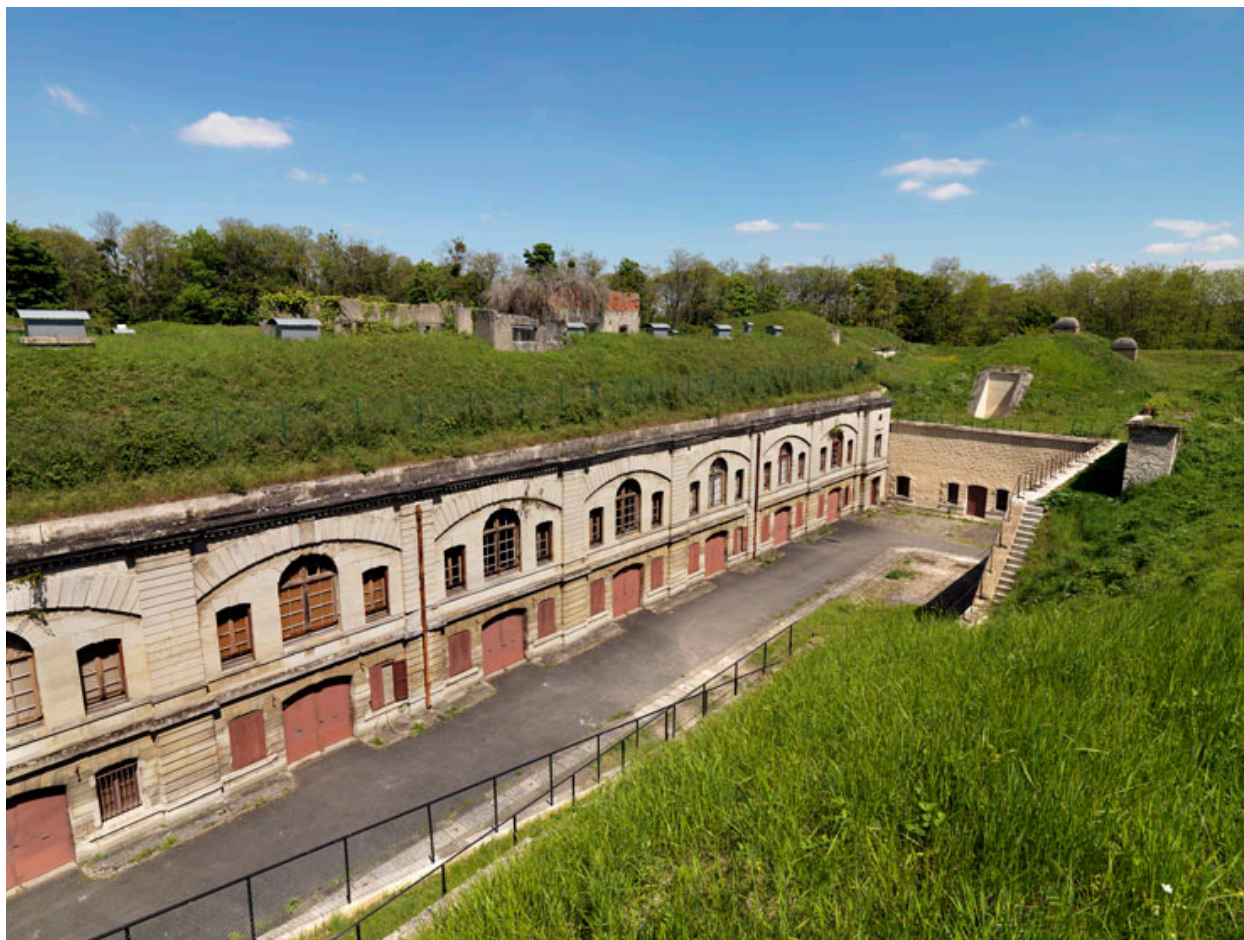
La caserne vue depuis le sommet du rempart, au sud-ouest.
