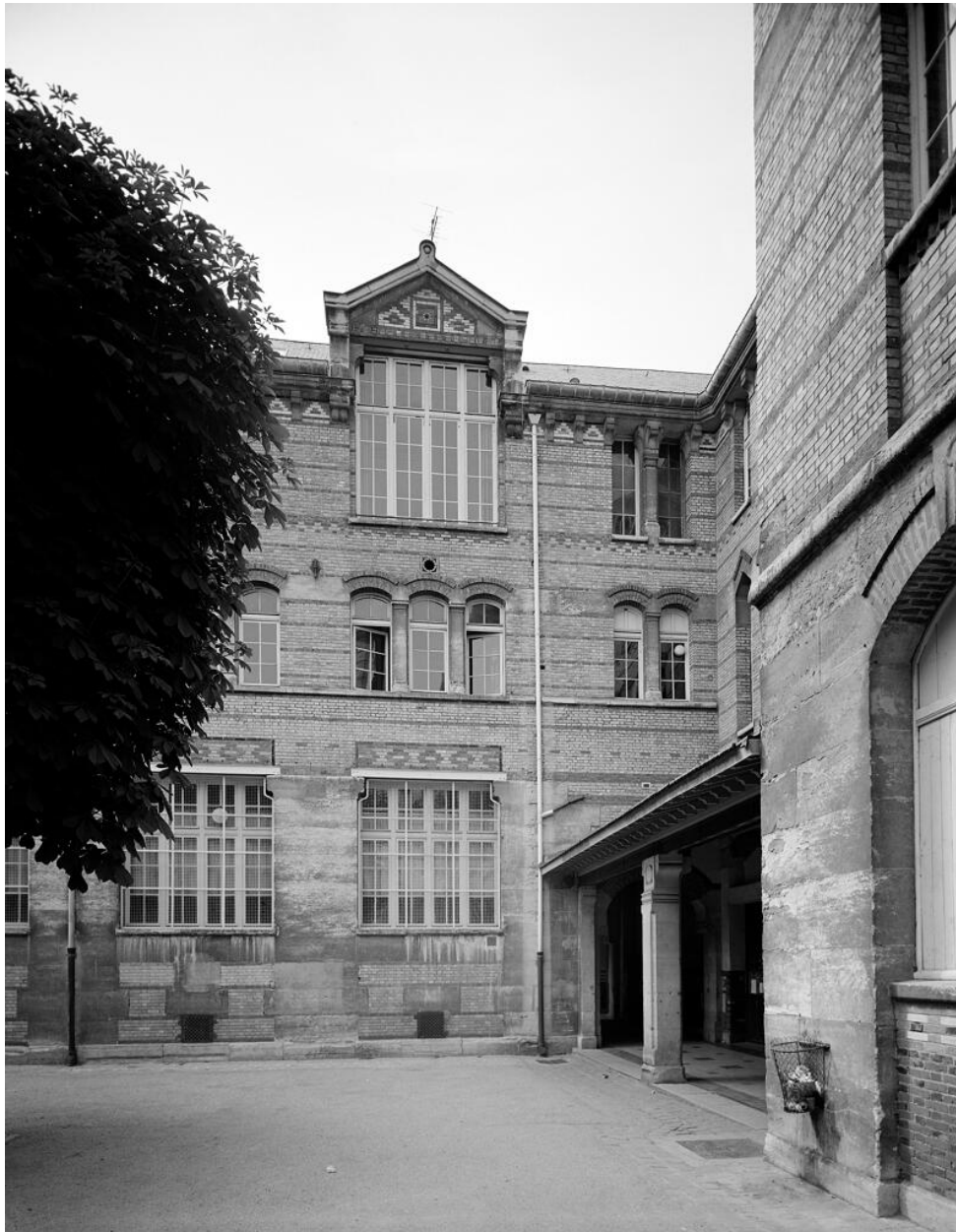
Cour des petits : Façade nord de l'aile séparant la cour des moyens de celle des petits. Les fenêtres du rez-de-chaussée éclairaient le jardin d'hiver. Lycée dit Lycée Lakanal
