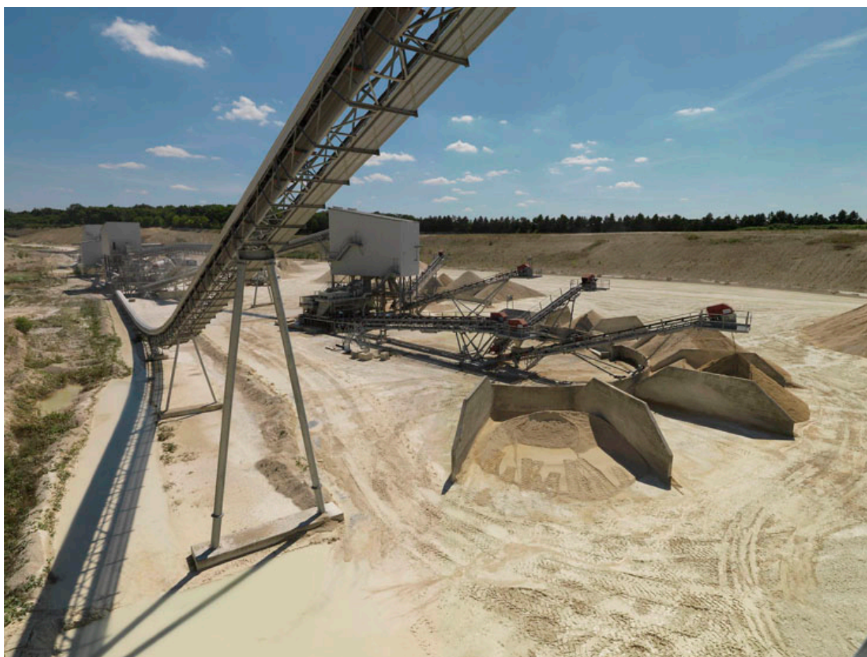
Plateforme - installation secondaire.
