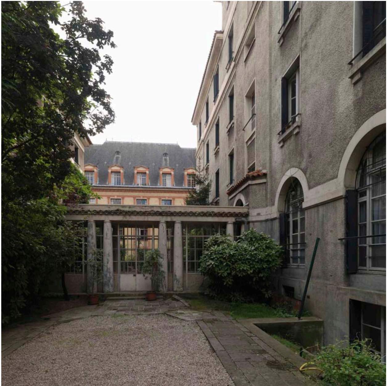
Vue de la partie ouest du jardin intérieur avec la galerie de liaison entre les deux bâtiments.
