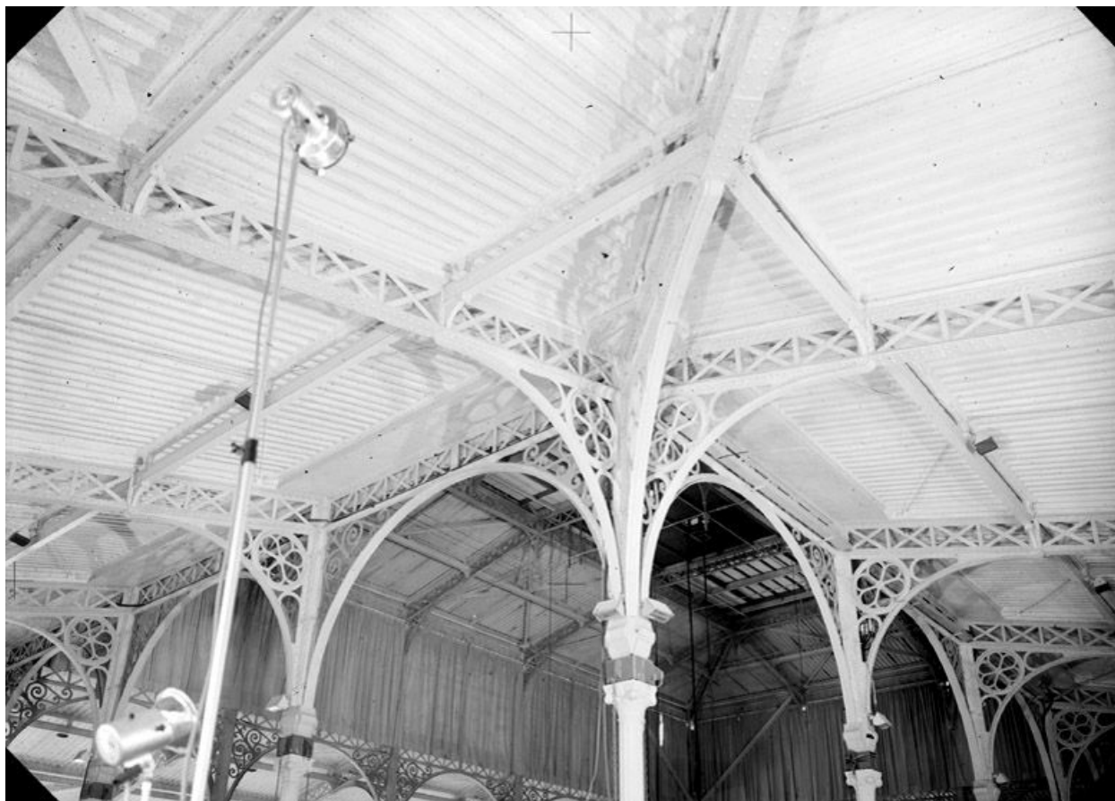
Jonction des fermes transversales. Couple photogrammétrique.
